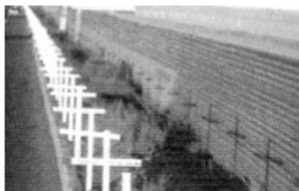
Fig. 2: Muro de Tijuana
